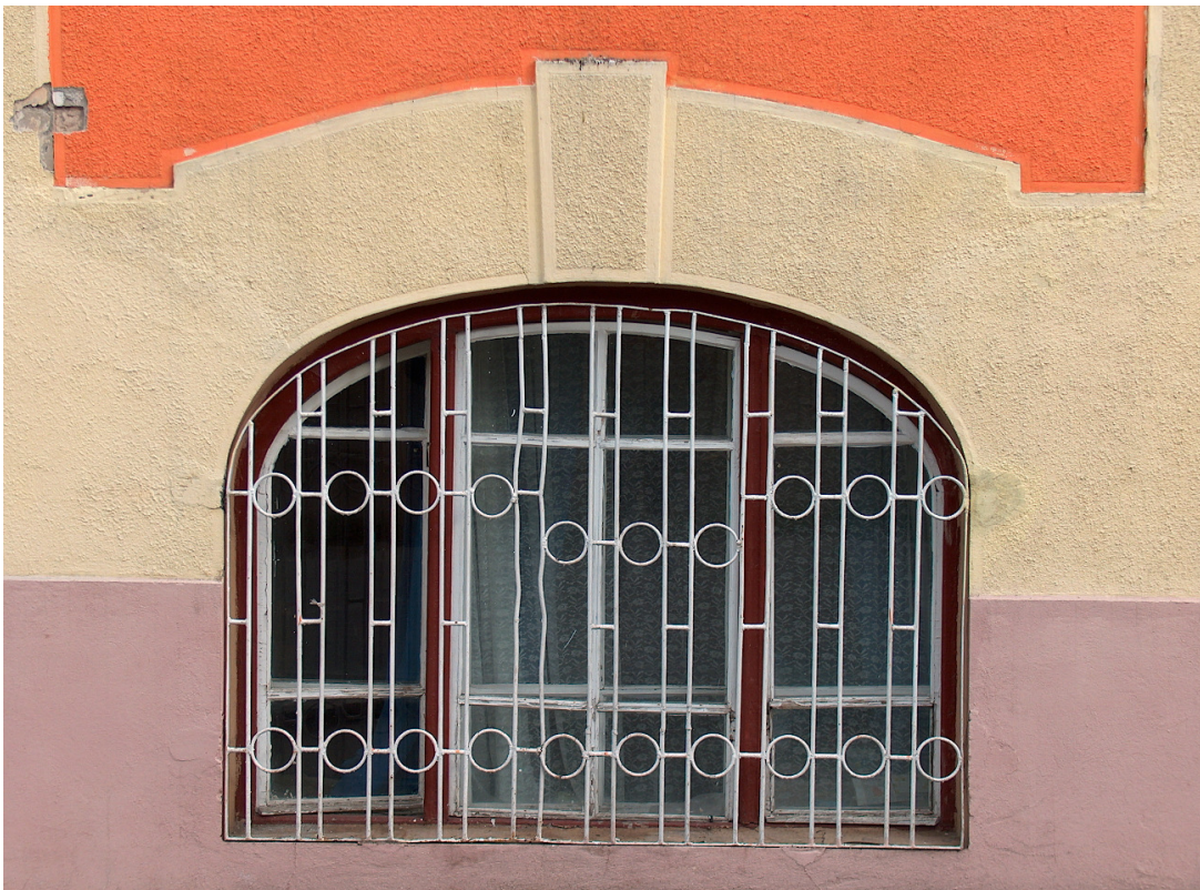
Fereastră de la parte, fațadă principală, corp B
