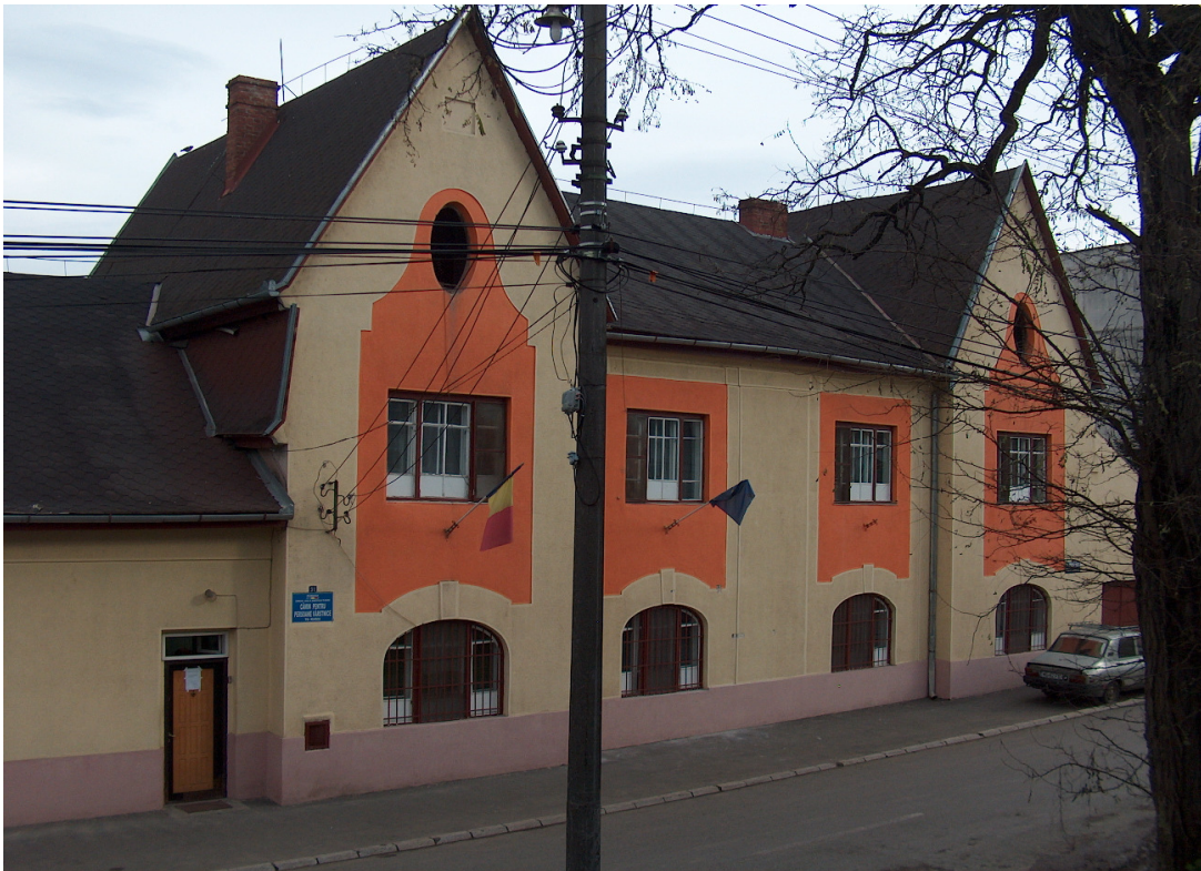
Fațada principală – corpul B
