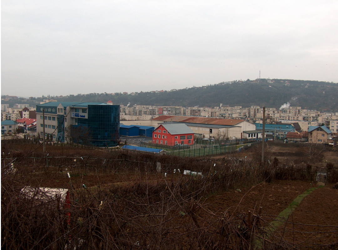
Teritoriul fostei fabrici de cărămizi, corpul B este marcat cu săgeată
